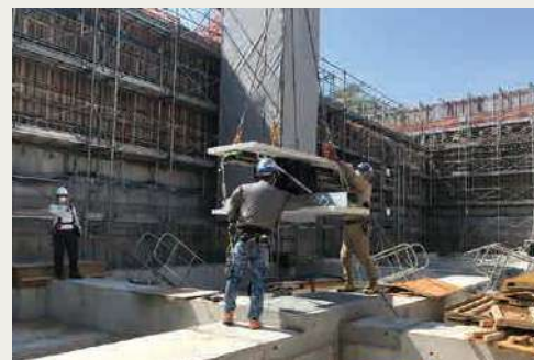
免震装置(滑り支承)設置状況
