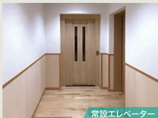
常設エレベーター
